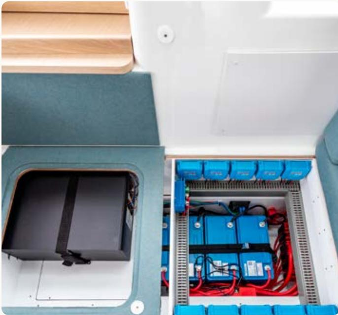
Das Herzstück ihres Stromversorgungssystems bilden zwei 3-kW-Quattro-Wechselrichter/Ladegeräte, die Haushaltsgeräte mit 230 V Wechselstrom aus dem 12-VDC-Batteriespeicher des Bootes versorgen.
